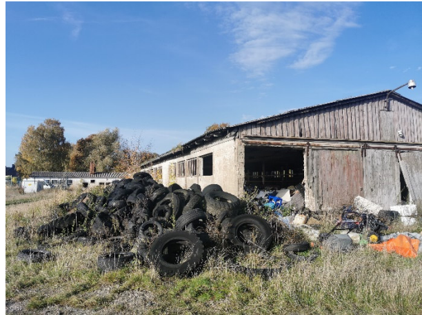
Abbildung 6: Reifen und Bauschutt ablagerungen im Plangebiet, 08.05.2023.
