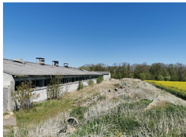
Abbildung 4: Östlicher Wall außerhalb des Geltungsbereich, 05.05.2023.
