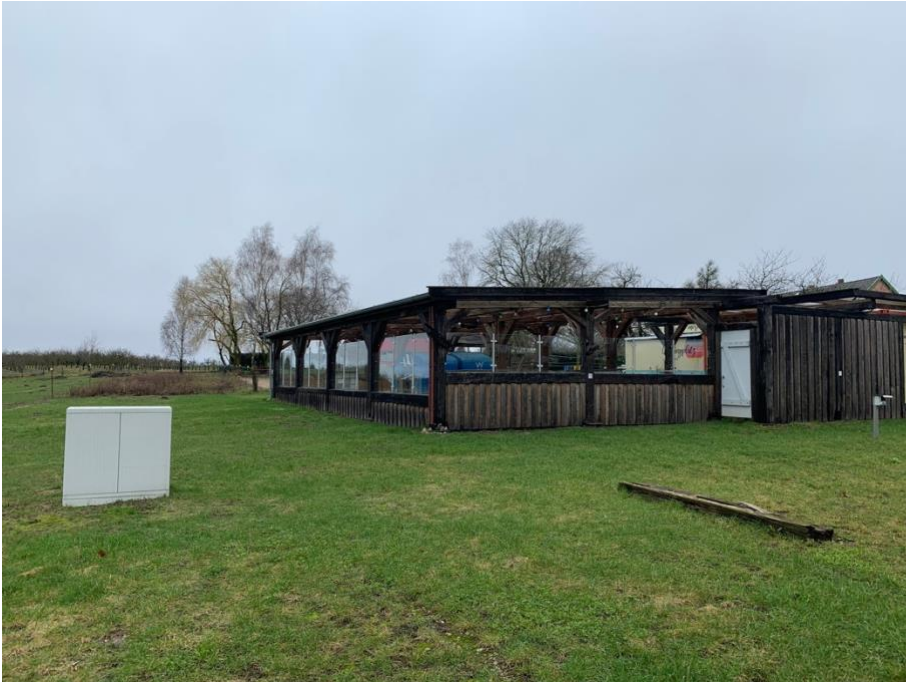
Abb. 8: Flachbau für die gastronomische Nutzung (Feb. 2024)
